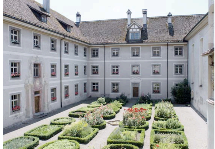
Renovationen bei Kloster Fahr, Würenlos, ZH
